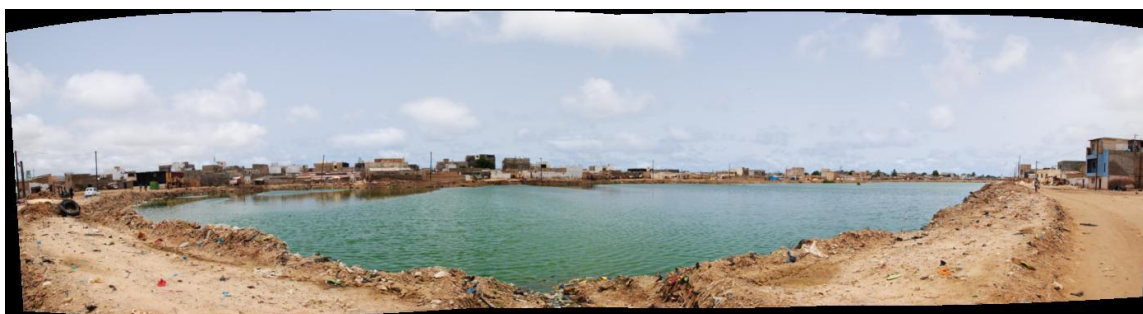
Figure 9 : Bassins situés derrière les locaux du CADDTK, affleurement de la nappe phréatique polluée
